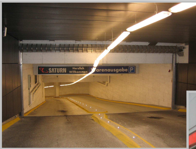
BILD OBEN: Rollgittertor in der Parkgarage
